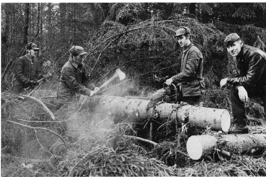
När skogen tynger ner kablar uppstår en spännverkan på bärvajrarna, och därför faller träden praktiskt taget hur som helst efter fällningen. Röjningsmannskapet riskerar alltså hela tiden att få fallande träd över sig, men lyckligtvis har arbetet gått olycksfritt hittills. Vpl 551 Strand, Uddevalla, 609 Svensson, Sulvik och 11 Spjut, Dals Ed under l:e telereparatör Sune Larssons ledning.
