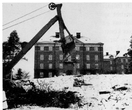
Kanslihuset i grävskopans skugga. Här grävs för nya E 18.
